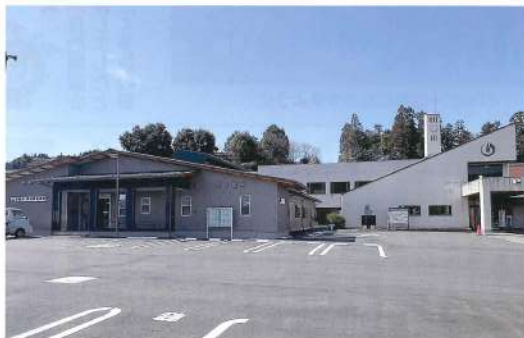
← 霊山総合支所新庁舎は左側です。
