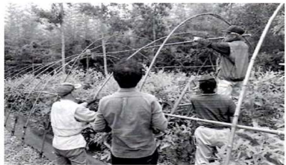
写真3 周囲の竹を利用してハウス建設
