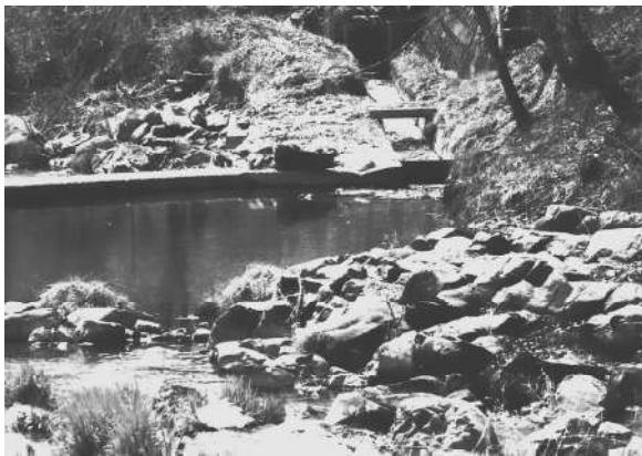
塩野川から水揚げする堰 観音溜池下流地点（通称上堰）
