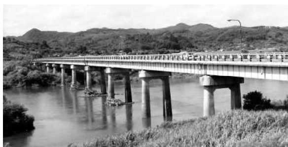
永久橋になった梁川橋 現在は新工法の梁川大橋がかかる
