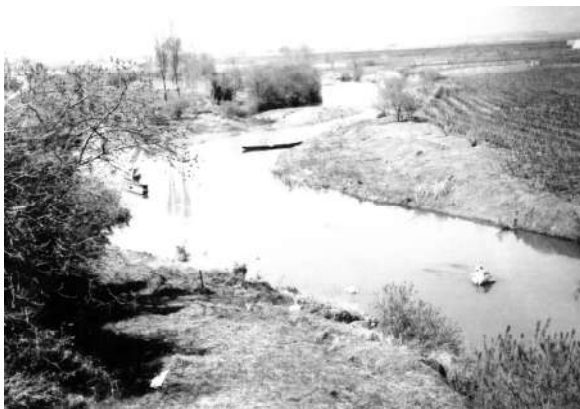
梁川旧河岸場付近（昭和50年代） 鬼石の下部らしい一部が残る
