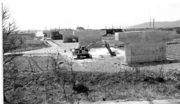
工事中の橋桁 349号バイパスの広瀬川にかかる部分の工事
