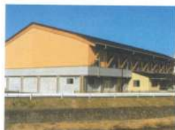
霊山町地域交流センター 霊山中学校体育館完成 (平成15年5月)
