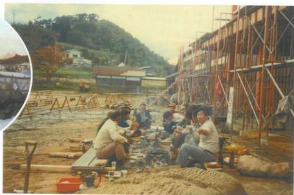
集落センター建設のコマ 請負業者 中川工業
