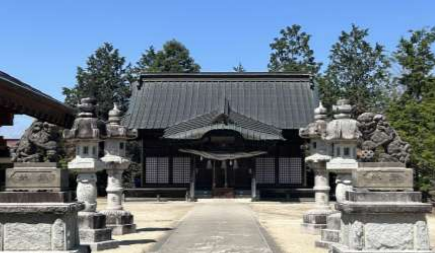
修復が完了した神社拝殿正面
