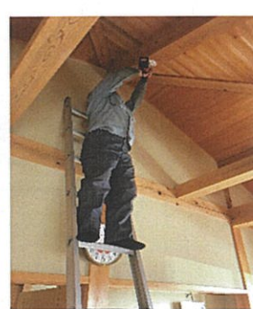
火災警報器取付
