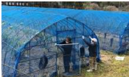
作業状況(ネット掛け)
