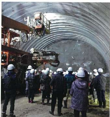
大型掘削機の説明を聞く
