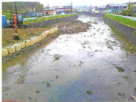
工事中の「町北橋」付近
