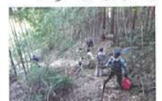
林道の整備作業
