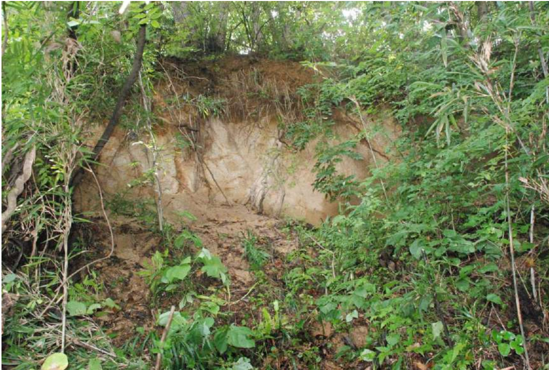
崩落した防空壕
