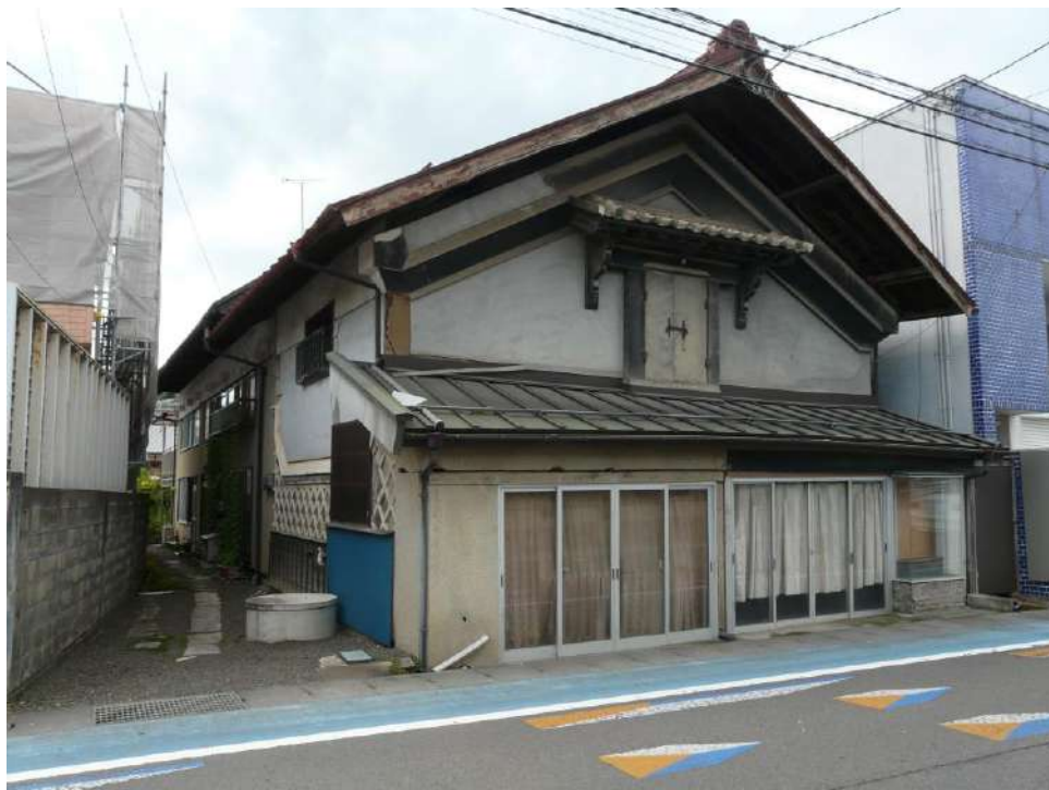
改装前の全景
