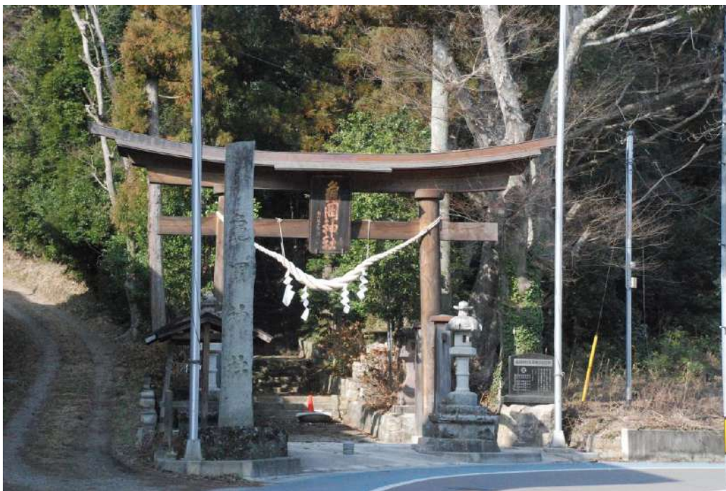
亀岡神社鳥居 天保6年建立、老朽化により 平成8年5月 建て替えられました。
