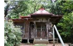
観音堂（大石西館）
