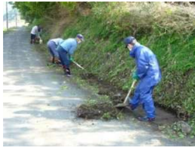
側溝付近の表土の剥ぎ取り作業 (平周辺)
