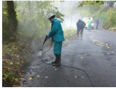
高圧洗浄機で道端を除染 (坊ノ内地区)
