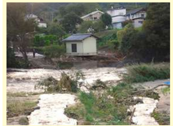
大関東木田橋から東側を撮影。小屋の基礎部分が損傷しています。
