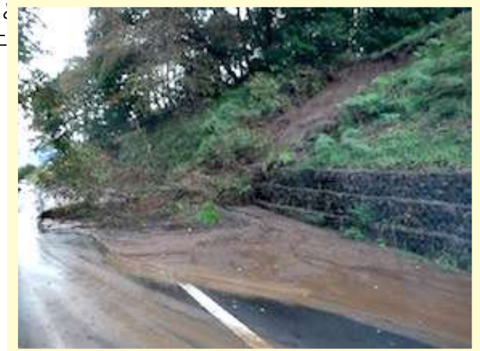
大関笠石地内、小学校手前と JA の間、右は笠石観音。道路は軽自動車を通れる程度でした。
