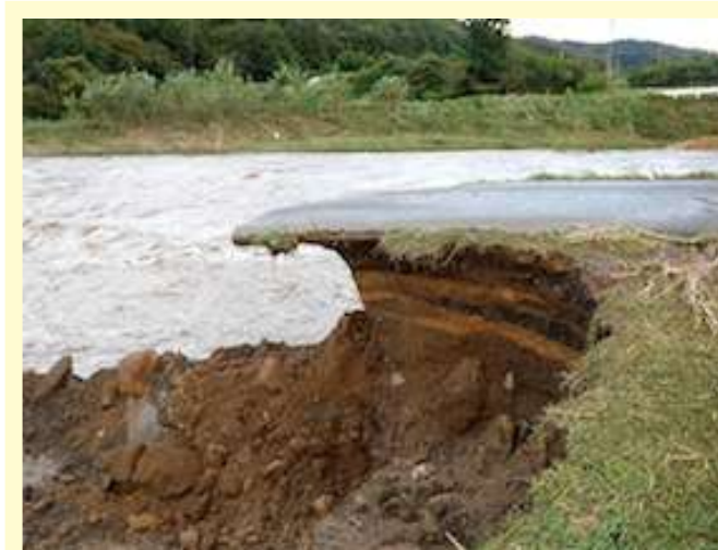
右の大日橋の手前から北に通る川沿いのアスファルト道路は完全に寸断です。
