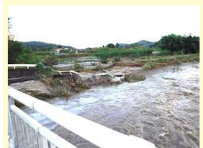
大関大日橋から東側を撮影。こちらは完全に堤防が破壊されています。
